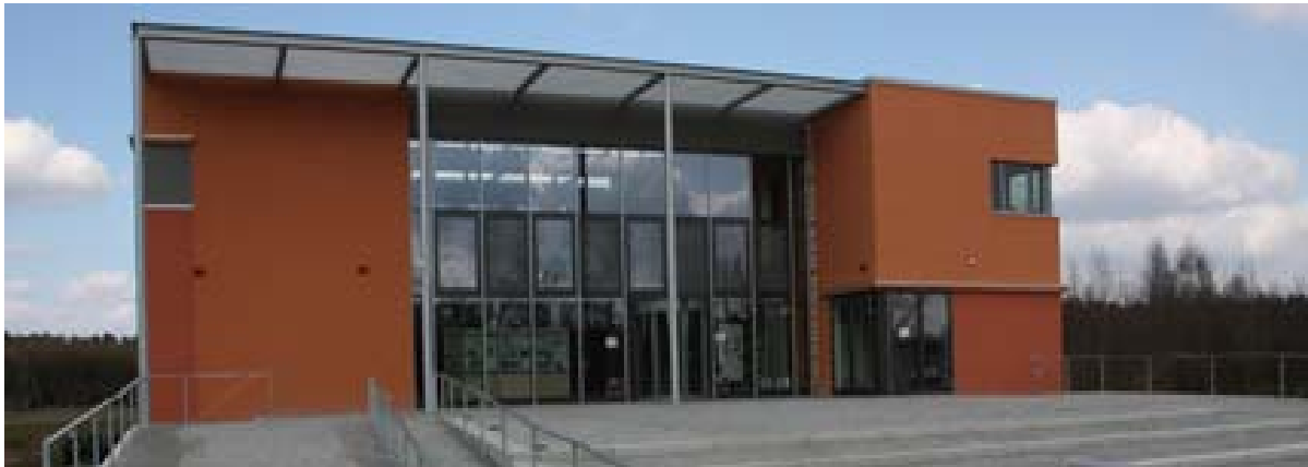
Bibliotheksgebäude auf dem Campus der Theologischen Hochschule Friedensau © Foto: Freikirche der STA
